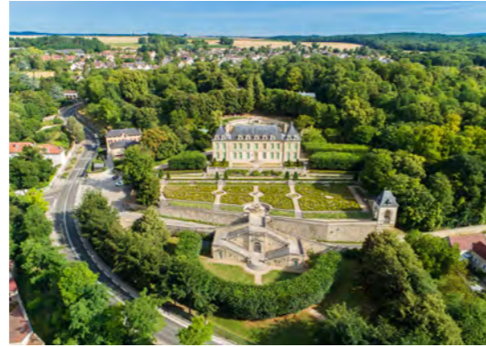
2 Château d'Auvers, drone (2018) © Le Square
