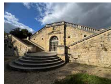
9 Château d'Auvers, orangerie sud ©Château d'Auvers
