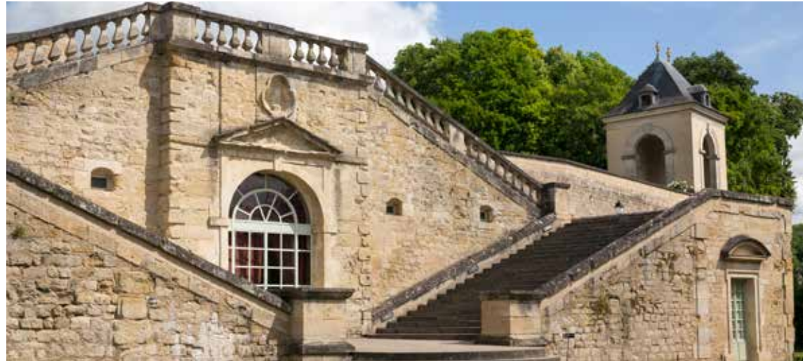
Château d'Auvers, orangerie sud (2018) ©J-Y Lacôte
