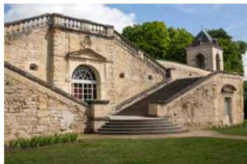
1 Château d'Auvers, orangerie sud ©Château d'Auvers
